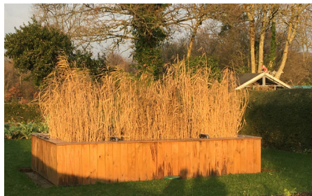
AQUATIRIS filtre vertical maçonné en hiver.
